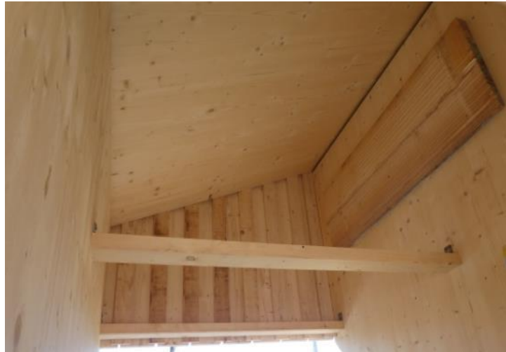
Abb. 4 Neues Fledermausbrett an der rechten Wand bevor noch eine Decke eingezogen wurde (Foto: H. Liebel).
