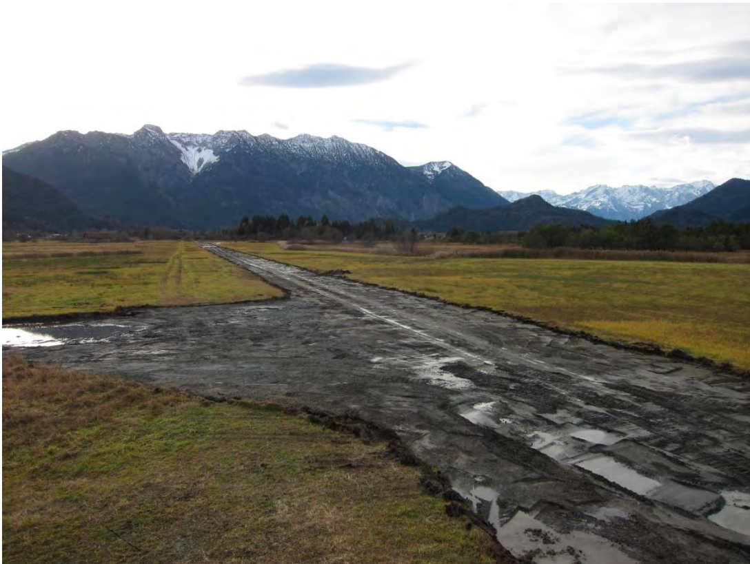
Abb. 31 Landebahn während des Rückbaus, 21.11.2016 (Foto: H. Liebel).
