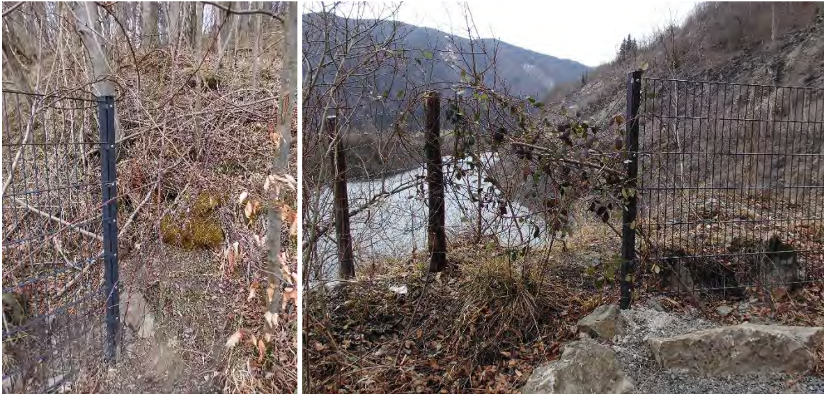
Abb. 38 Provisorischer Verbau der Schlupflöcher zum Steinbruch des Langen Köchels (Foto: H. Liebel).
