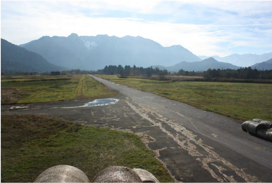
Abb. 30 Landebahn des ehemaligen Segelflugplatzes bei Weghaus vor dem Rückbau, 04.11.2016 (Foto: H. Liebel).
